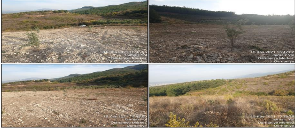
C2.DY6 Depolama Tankı ve TMY-C1 Terfi Merkezi
