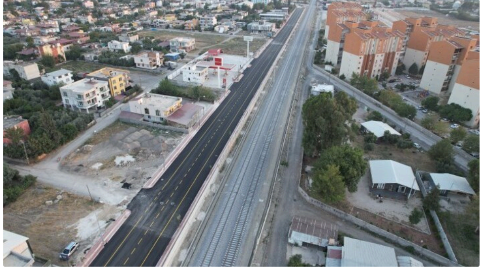
Görsel 4: Asfalt serim çalışmalarından havadan görünüm.
