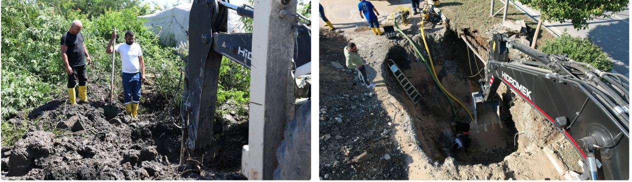
Görsel 43: Su arıza müdahale çalışmaları — kazı ve boru onarımı.
