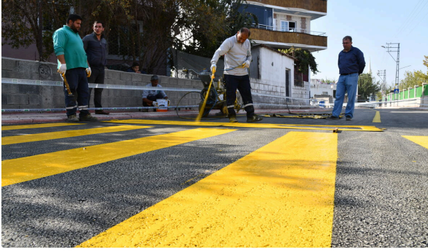
Görsel 47: Yaya geçidi çizgi çalışması ve tamamlanmış yol işaretlemesi
