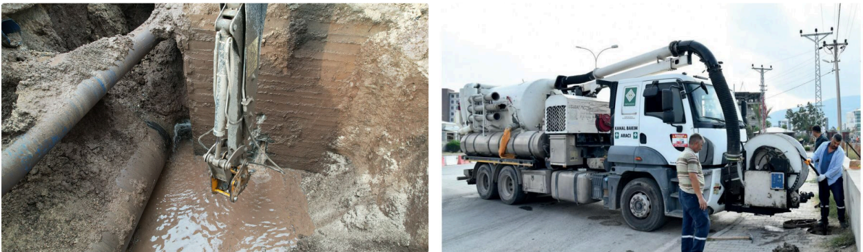
Görsel 44: Ana hat boru döşeme (solda) ve kanal bakım aracıyla tıkanıklık müdahalesi (sağda).
